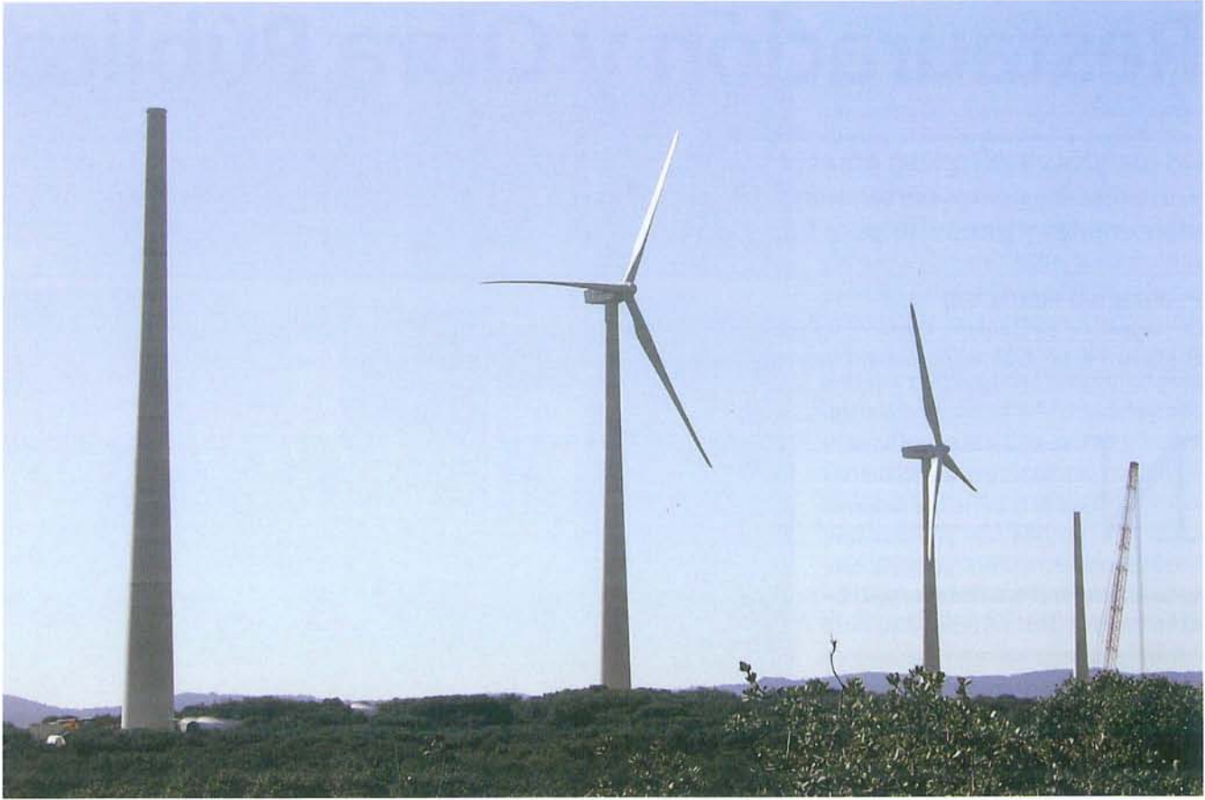
Aerogeneradores modelo Alejandria, prefabricados de hormigón. Esteyco, Inneo.
